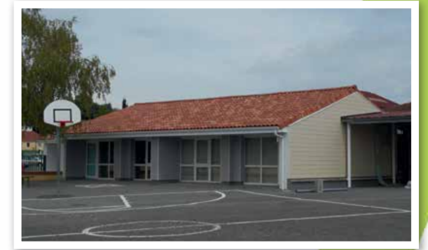
D'importants travaux ont été réalisés au groupe scolaire.
